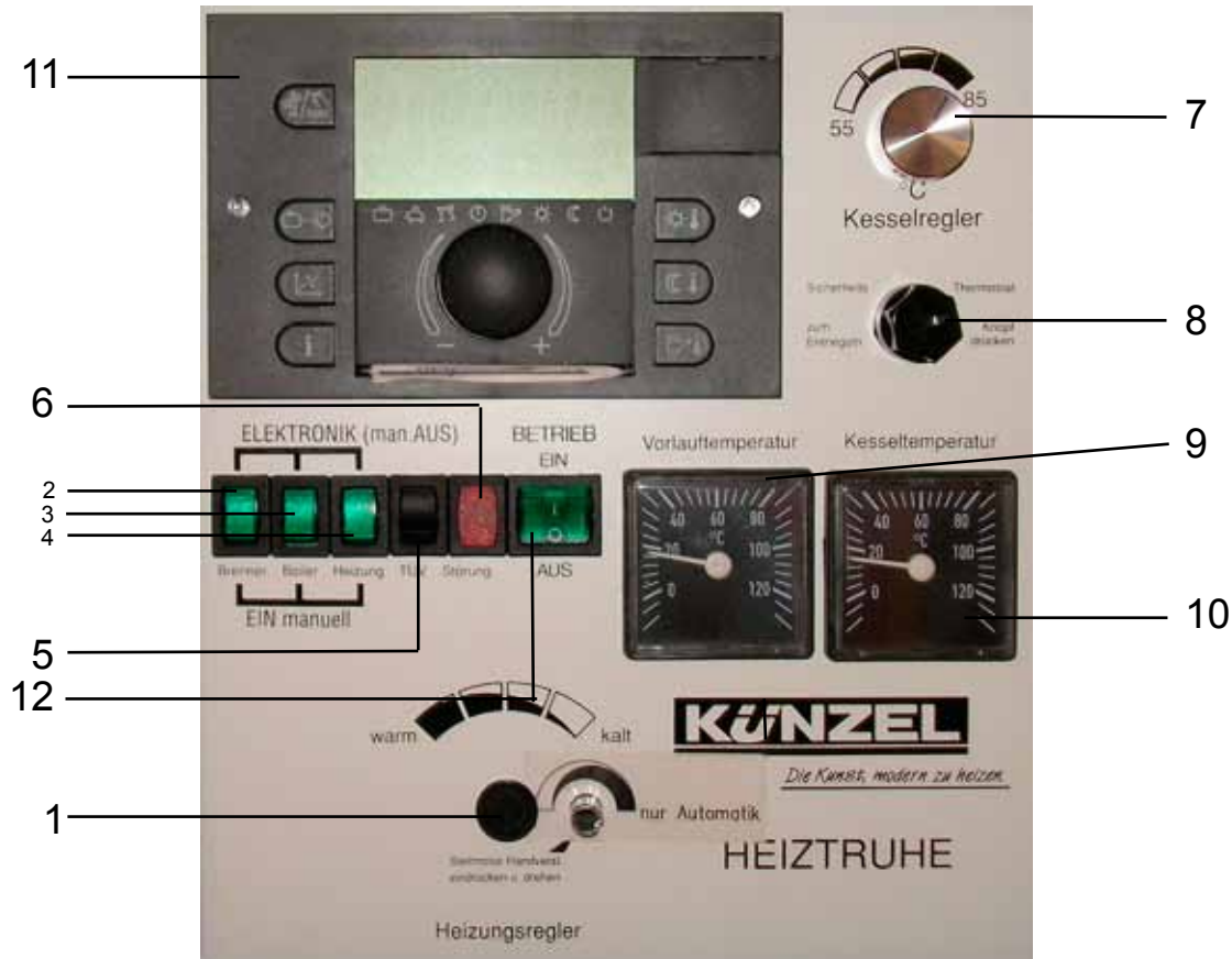
Abbildung 2: Das Schaltfeld mit integrierter witterungsgeführter Regelung
